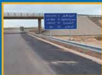
LABORATOIRE D'EL JADIDA AUTOROUTE SIDI SMAÏL / SAFI
